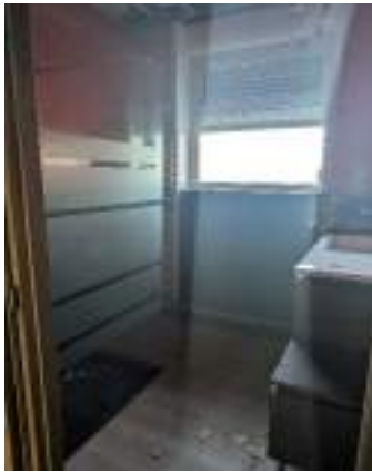
RDC / salle de bains
