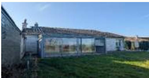
Façade de l'existant sur jardin
