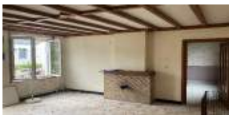
RDC Séjour (future salle à manger)
