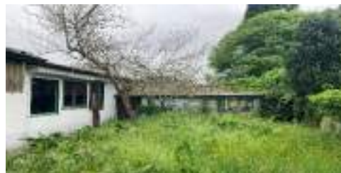
A l'arrière du bâtiment
