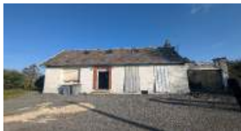
façade de l'existant sur rue
