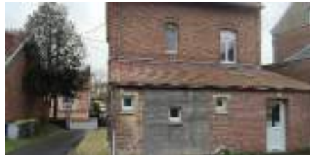
A l'arrière du bâtiment
