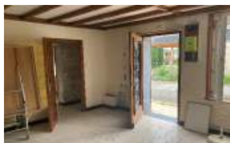
RDC entrée actuelle remplacée par une porte-fenêtre
