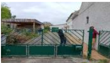
Façade de l'existant sur rue
